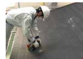
②垂木の墨出しラインにクイックスレート金具のスレート金具ビス孔の墨を出します。
