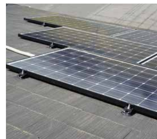
⑥T型ボルト、パネル押え金具を取付けます。
