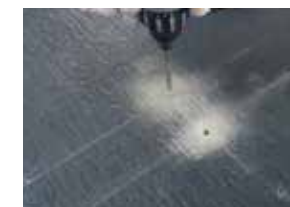
③電動ドリルを使用してクイックスレートのビス孔を開けます。
