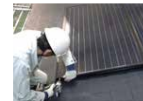
⑧軒先カバー、間カバーを取付け本締めします。
