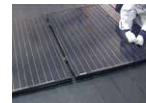
⑦モジュールを設置して、パネル押え金具で仮固定します。
