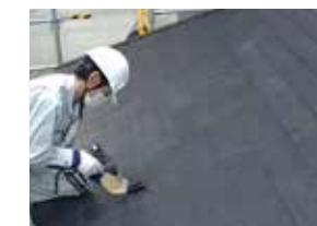
④クイックスレート金具に合わせて、ビスを打ち込み固定させます。
